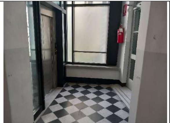
ASCENSORE A NORMA
