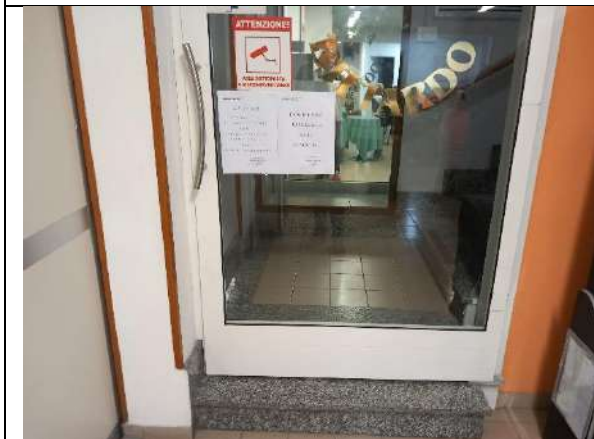
PORTA, SU PIANEROTTOLO, DI ACCESSO AL PIANO SUPERIORE
